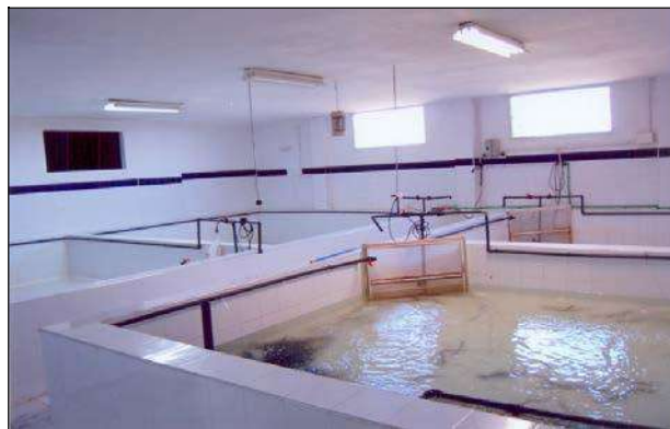
Figure 105 : Bassins cimentés, avec carrelage
