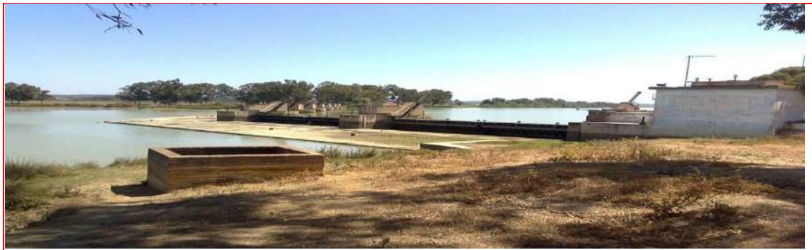
Barrage de garde du Loukkos
