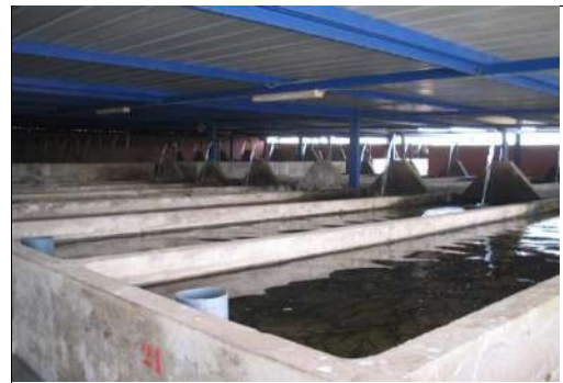
Bassin en ciment
