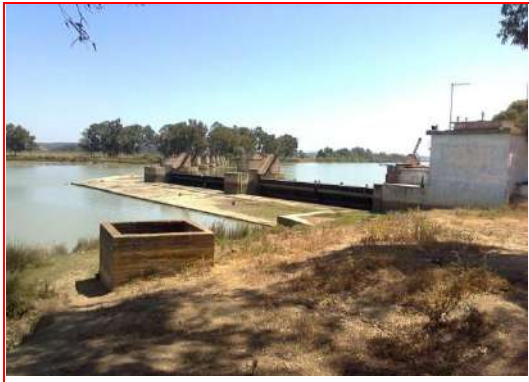
Barrage de garde du Loukkos
