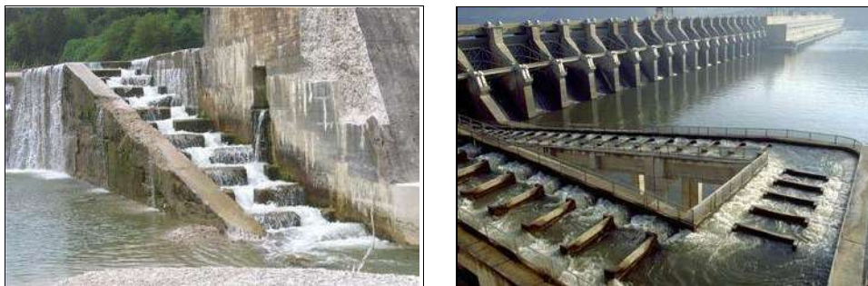
Figure 14 : Types d'échelle à poissons
