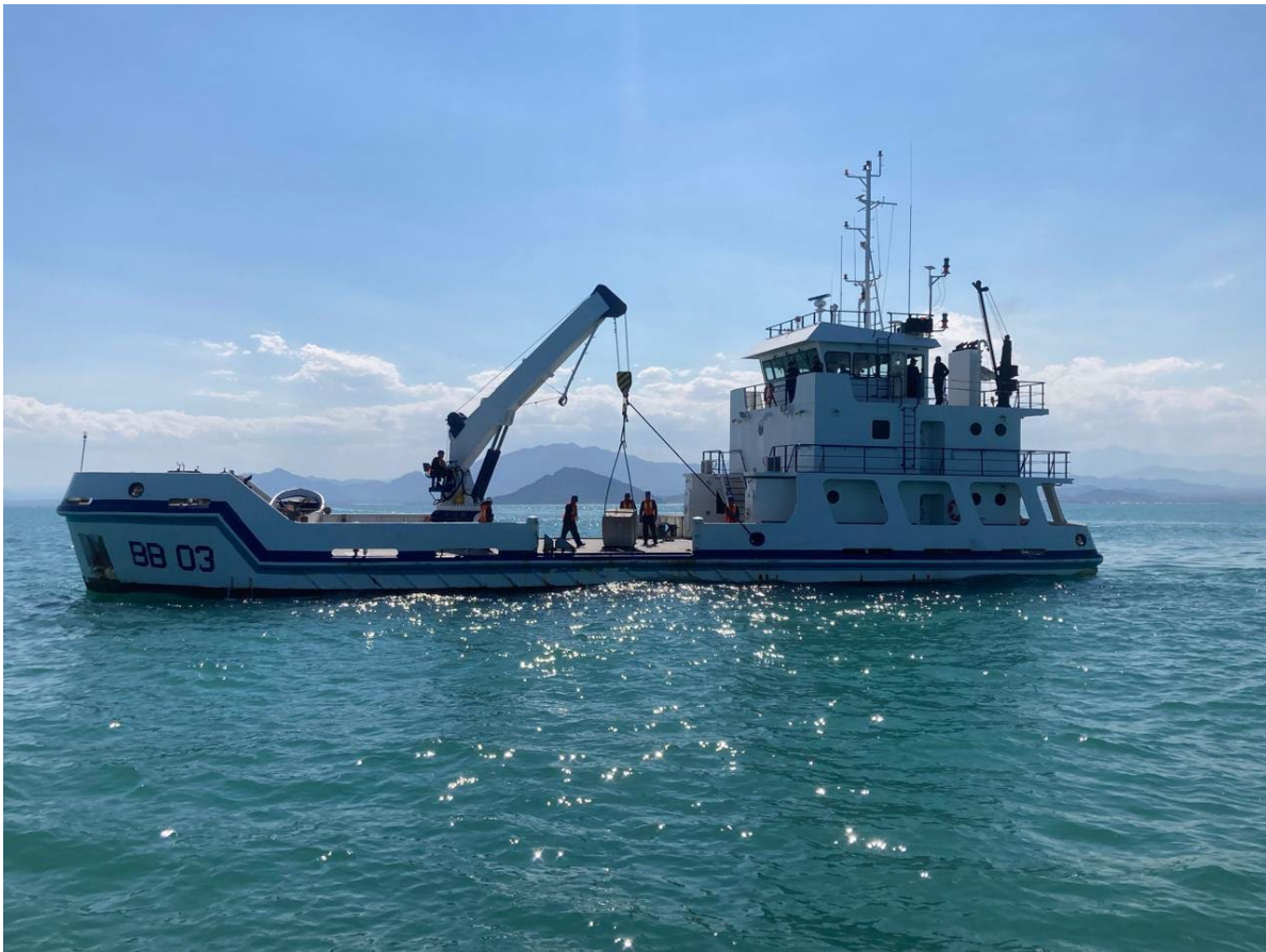
Imagen 13. Colocación de bloque de concreto
