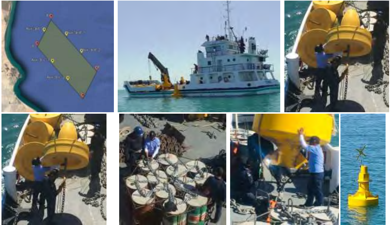
Galería fotográfica#3. Instalación de las boyas en el ATC.
